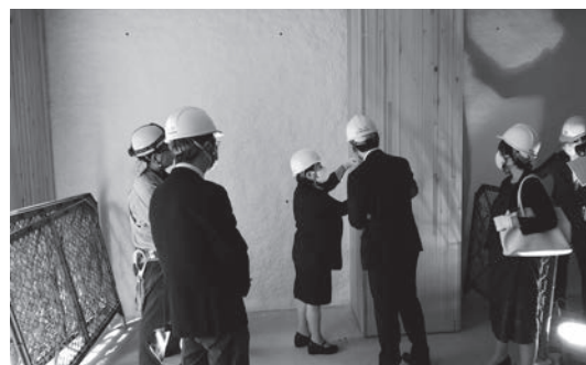
2021.5.28 グリーンインフラWTで12階建木造商業施設建築現場を視察
