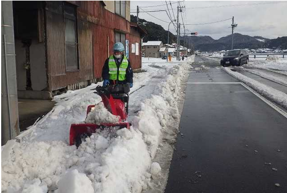
小型除雪機による歩道の除雪（島根県安来市）
