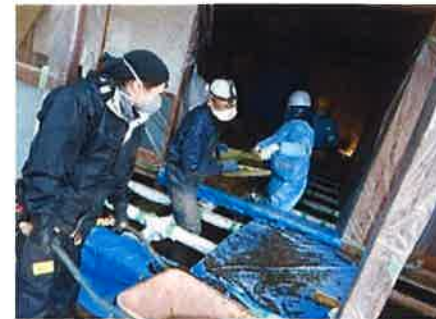
床下の泥の撤去 (宮城県丸森町)
