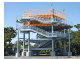
津波避難タワー
